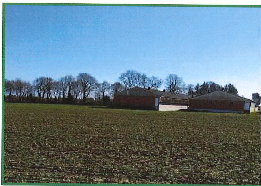
Photographie 4 vue nord ouest avant projet
